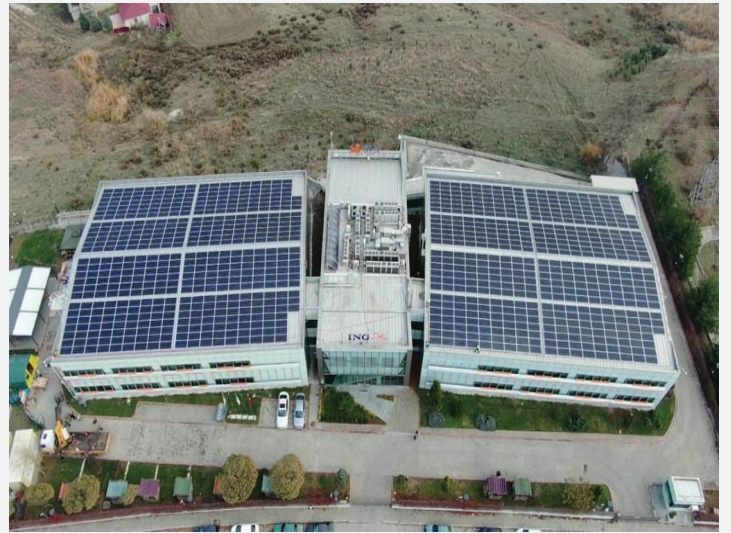
ING GES, 400 kW, Kahramanmaraş
