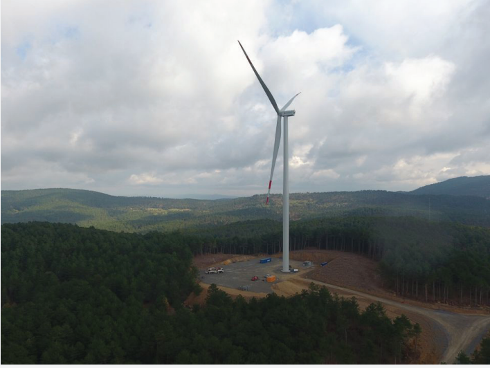
Türkerler RES, 55 MW, Balıkesir
