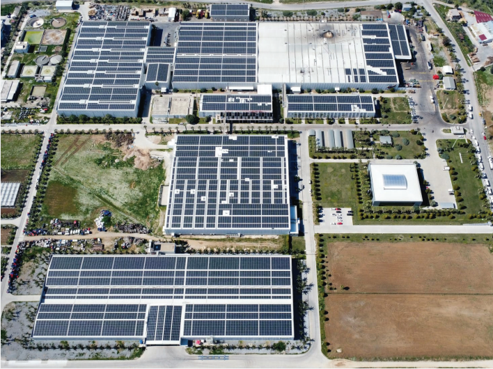
Özgörkey Çatı GES, 8.9 MW, İzmir
