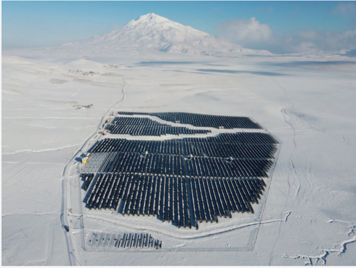
Adilcevaz GES, 23 MW, Bitlis
