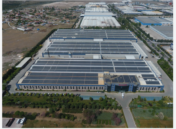
Bürotime GES, 10.5 MW, Konya
