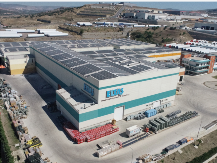
Eltaş Transformör Çatı Ges, 3 MW, İzmir
