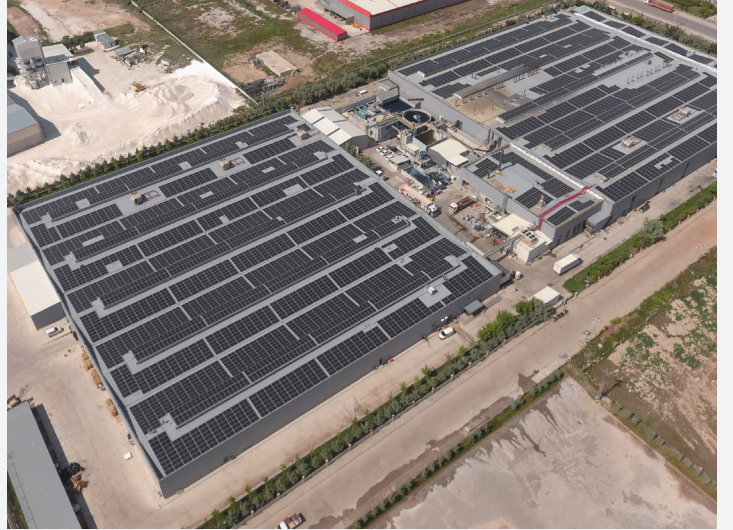
Eroğlu Çatı GES, 3.3 MW, Aksaray
