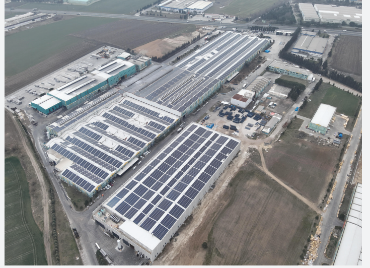
Sistem Alüminyum Çatı GES, 6.5 MW, Tekirdağ
