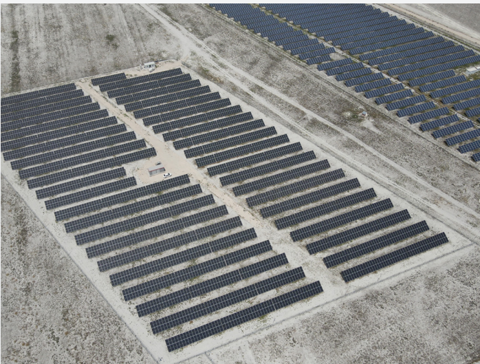
Naturelgaz GES, 2.4 MW, Konya
