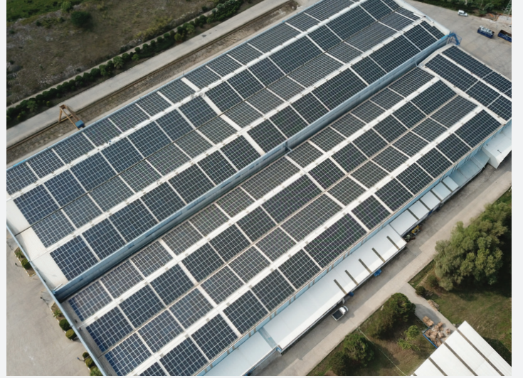
Tat Metal ÇSM-2 Çatı GES, 2.4 MW, Zonguldak
