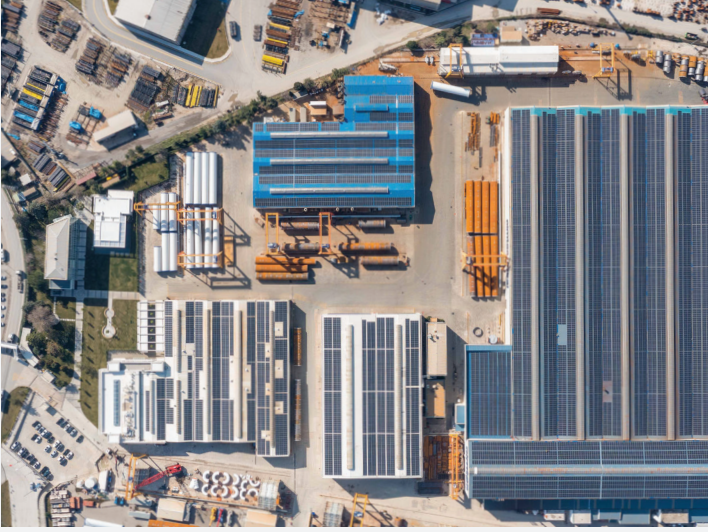
Çimtaş Çelik Çatı GES, 5.7 MW, Bursa
