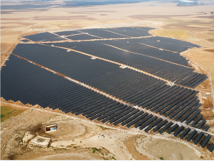
Yeşilyurt Arazi GES, 96 MW, Şanlıurfa
