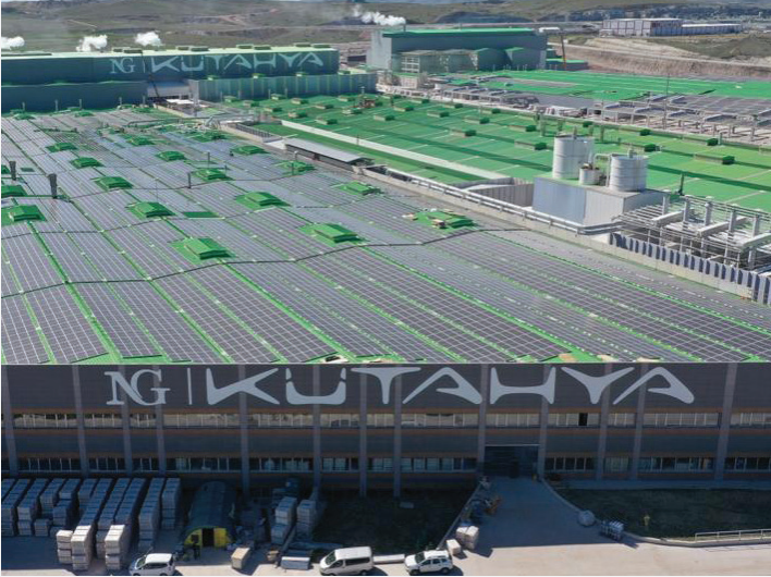
NG Kütahya Çatı GES, 3,9 MW, Kütahya
